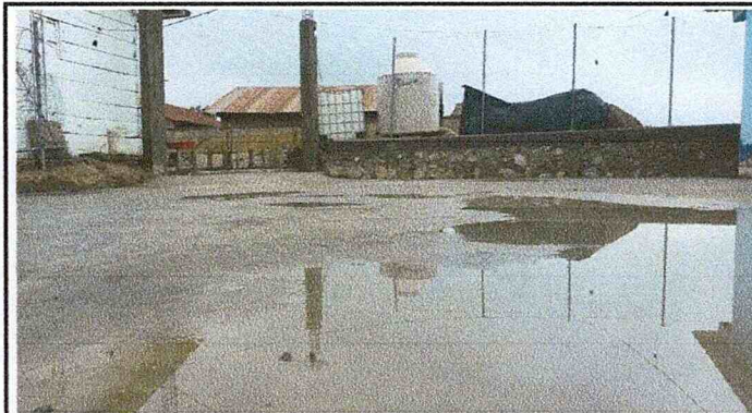
Foto 3: Plancha de concreto de patio sustituido
