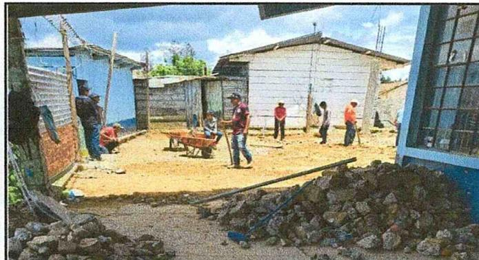
Foto 3: Nivelación de patio para sustitución
