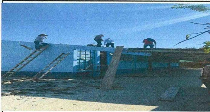
Foto 1: Desmantelamiento de techo de fibrocemento
