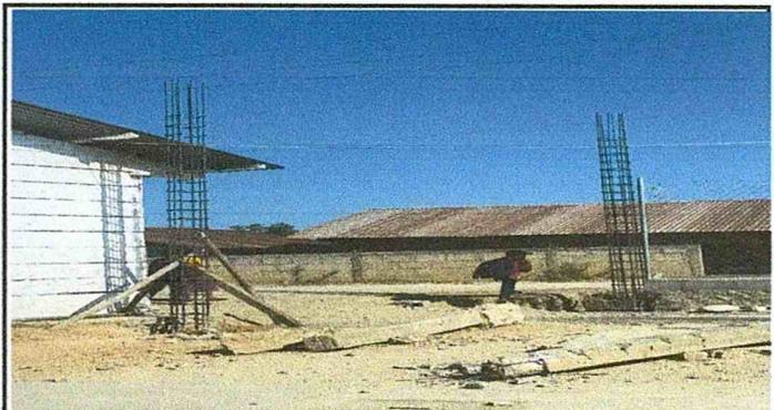
Foto 2: columnas para colocar portón
