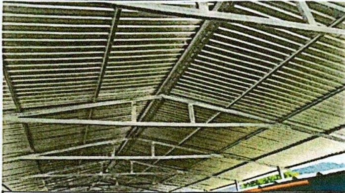
Foto 1: sustitución de lámina por lámina troquelada calibre 24
