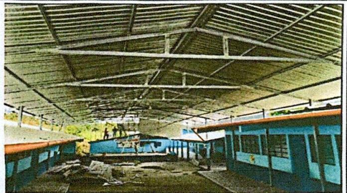
Foto 2: sustitución de lámina por lámina troquelada calibre 24
