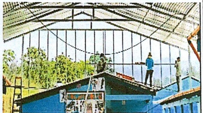
Foto 4: sustitución de costanera por tubo portante
