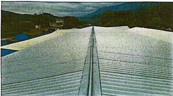
Foto 3: sustitución de capote por capote calibre 26 para lámina troquelada
