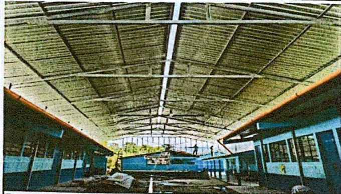
Foto 1: sustitución de lámina por lámina troquelada calibre 24
