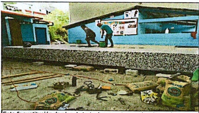
Foto 5: sustitución de piso de torta de cemento por piso de granito
