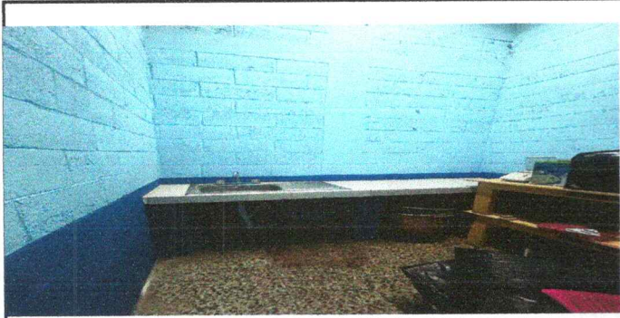
FOTO 1: COLOCACION DE AZULEJO EN PAREDES DE LAVATRASTOS
