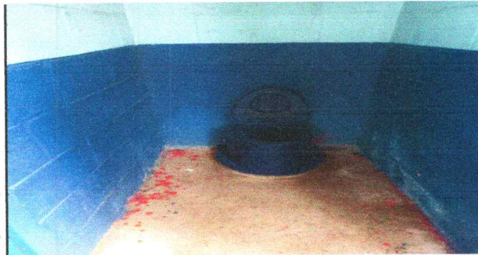
FOTO 3: SUSTITUCIÓN DE SANITARIOS
