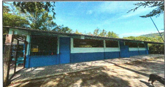
FOTO4: CAMBIO DE BALCONES
