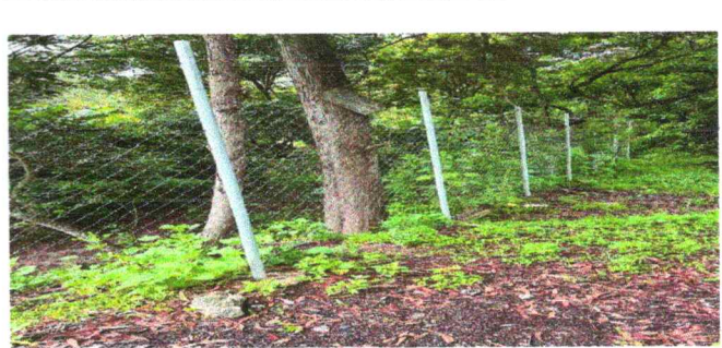
FOTO2: MEJORAMIENTO EN MURO PERIMETRAL DE BLOCK Y MALLA
