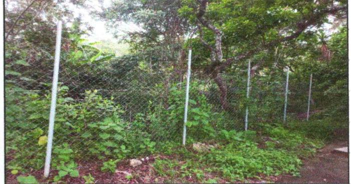
FOTO 2: REPARACION DE MURO PERIMETRAL DE BLOCK
