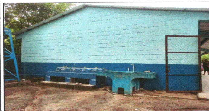
FOTO 5: SUSTITUCION DE PORTON
