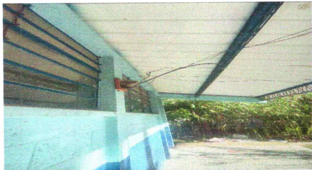
FOTO3: REPARACION DE CABLEADO ELECTRICO
