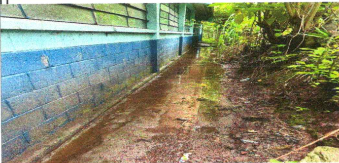
FOTO 3: MEJORAMIENTO DE CUNETAS PARA DESFOGE DE AGUAS PLUVIALES
