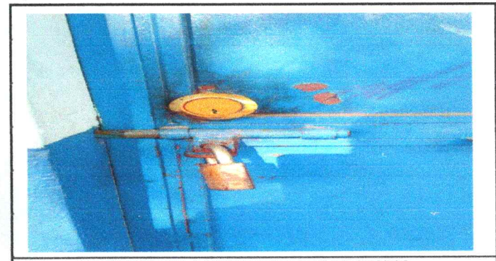
FOTO 6: MANTENIMIENTO A PUERTAS Y CAMBI DE CHAPAS
