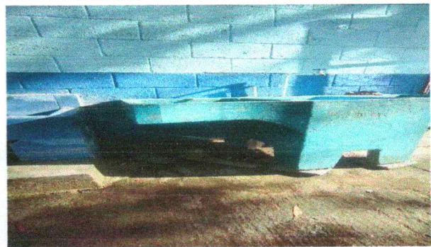
FOTO 4: SUSTITUCION DE PILA
