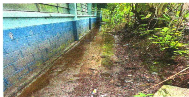
FOTO4: MEJORAMIENTO DE CUNETAS PARA DESFOGUE DE AGUA PLUVIAL
