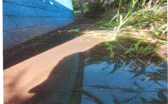
FOTO2: MANTENIMIENTO A CUNETAS
