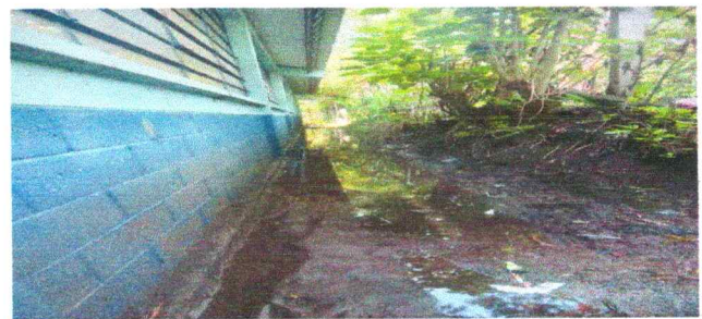
FOTO6: MEJORAMIENTO DE CUNETETA
