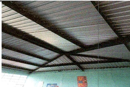
foto 1: terminación de enlaminado y mantenimiento de costaneras
