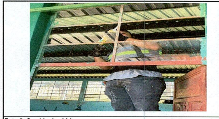
Foto 5: Cambio de vidrios
