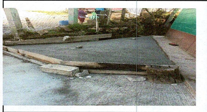
Foto 3: Pavimento para colocar la pila
