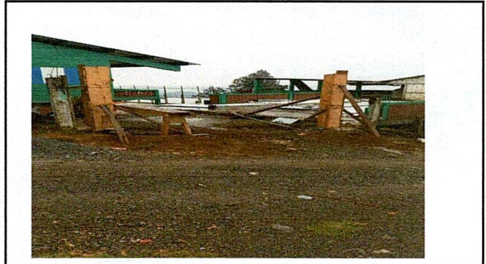
Foto 4: Columnas para el portón
