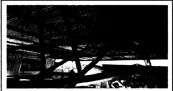
Foto 1: Lijado y pintado de estructura metálica techo por deterioro de pintura y presenta óxido.
