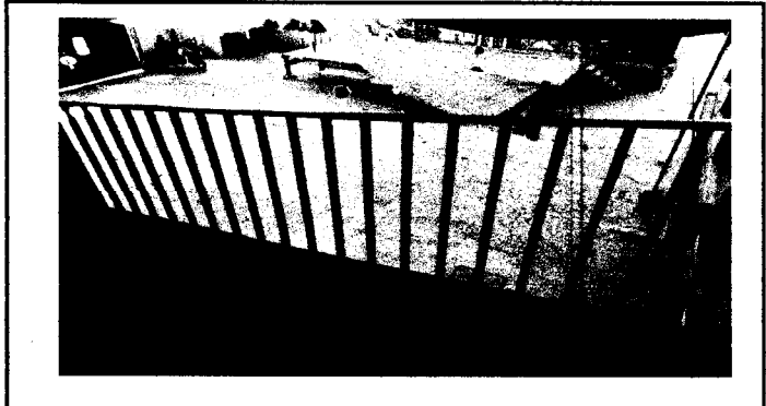
Foto 2: Lijado y pintado de baranda de rampa y segundo nivel, por deterioro de pintura.
