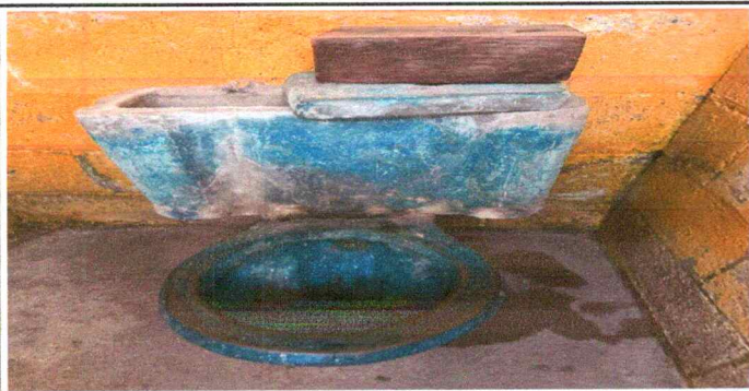
FOTO 3. SUSTITUCIÓN DE INODOROS
