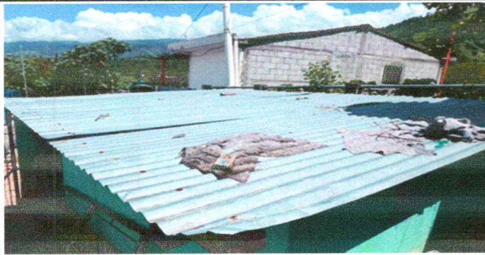
FOTO 1. SUSTITUCIÓN DE TECHO DE LÁMINA
