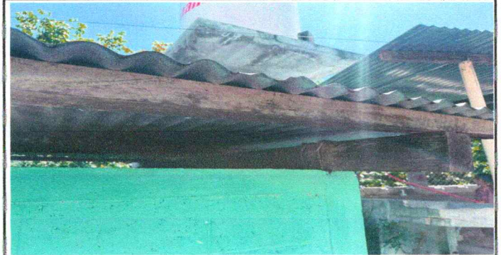
FOTO 2. SUSTITUCIÓN DE ESTRUCTURA DE MADERA
