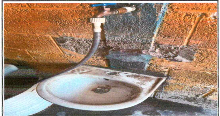
FOTO 4. SUSTITUCIÓN DE LAVAMANOS
