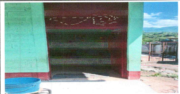
FOTO 5 SUSTITUCIÓN DE PUERTA DE METAL
