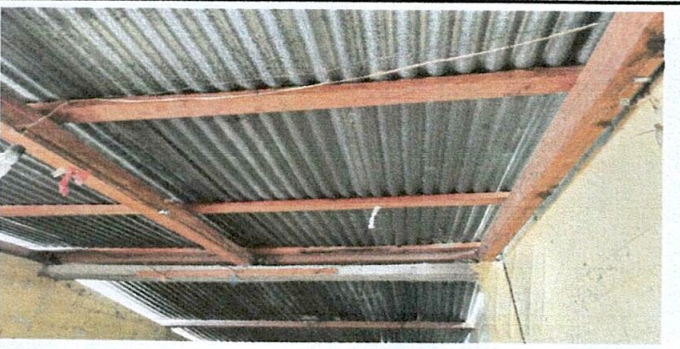
FOTO 5 Estructura de madera se sustituye por estructura de metal
