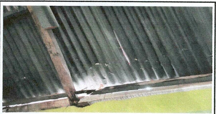
Foto 4: Vigas deterioradas.
