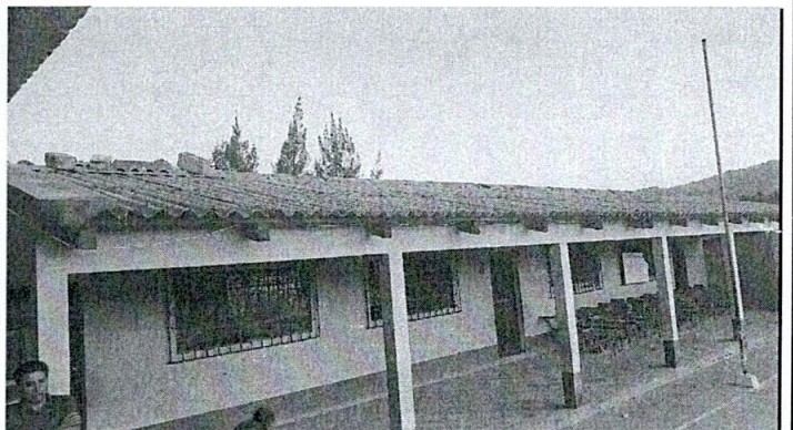
Foto 4: Sustitución de duralita por lámina troquelada calibre 26
