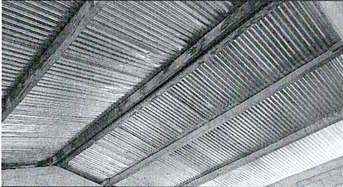
Foto 1: Sustitución de regla por costanera
