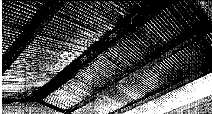
Foto 1: Sustitución de regla por costanera
