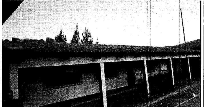
Foto 4: Sustitución de duralita por lámina troquelada calibre 26
