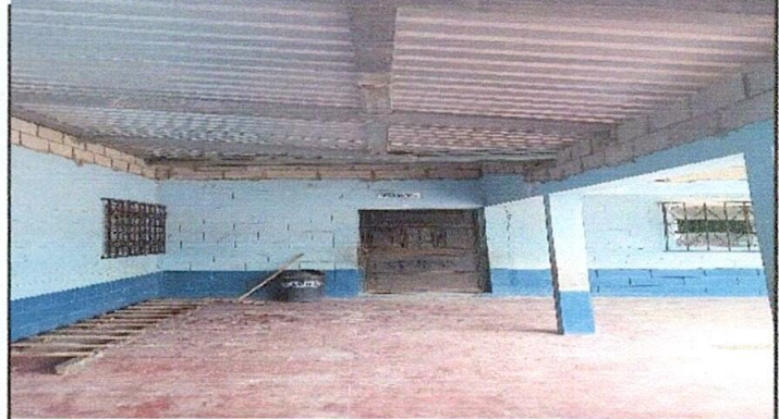
Foto 2. Finalización del techado del corredor de las aulas
