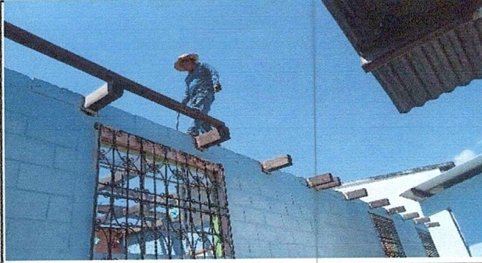
Foto 1. Demolición de la estructura del techo de las aulas
