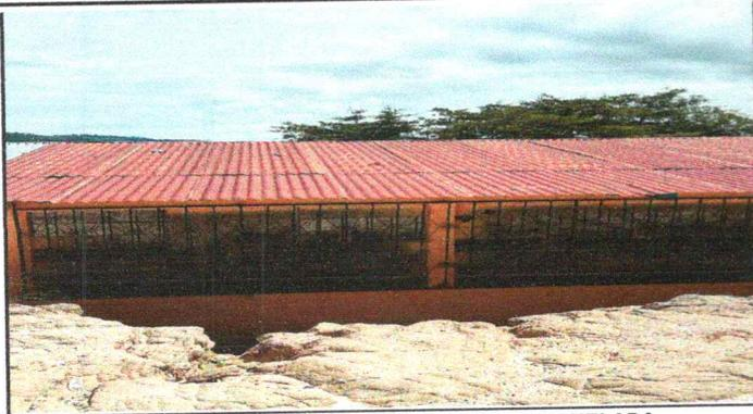
FOTO 1: SUSTITUCIÓN DE LAMINA POR LAMINA TROQUELADA
