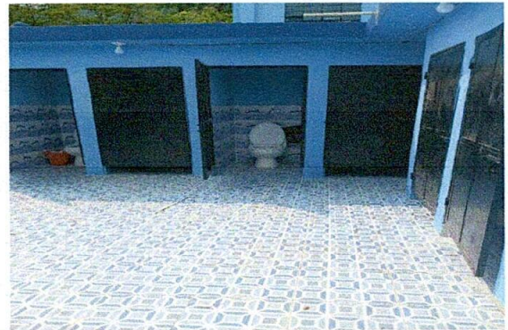
Foto 4: Terminación de azulejo y cerámico de los sanitarios.
