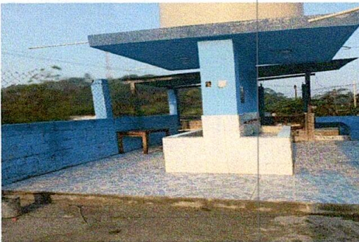
Foto 3: Culminación de luz eléctrica en los sanitarios
