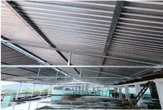
Foto1: SUSTITUCIÓN DE LAMINA POR LAMINA CALIBRE 26
