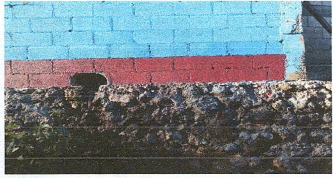
Foto 2: Reparación de muro perimetral.
