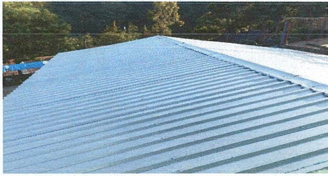
Foto 1: Sustitución de techo.
