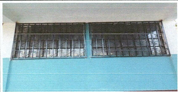
Foto 6: Sustitución de balcones.
