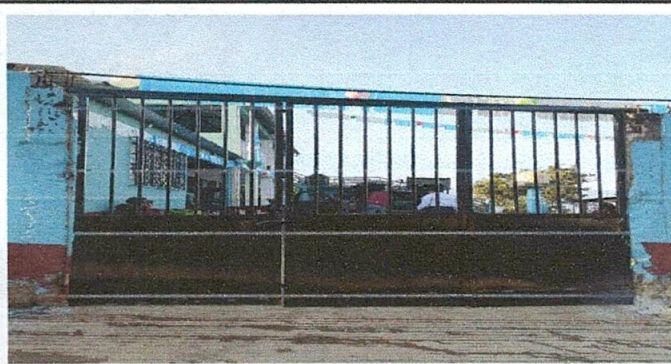
Foto 3: Sustitución de portón.
