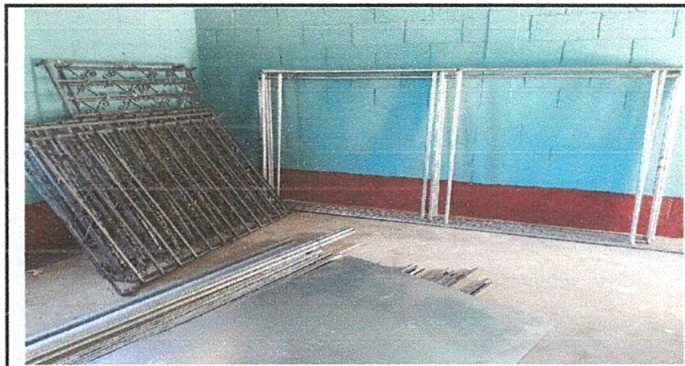
Foto 6: Sustitución de balcones.
