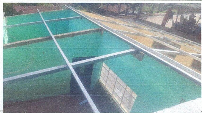
Foto 1: Sustitución de techo.
