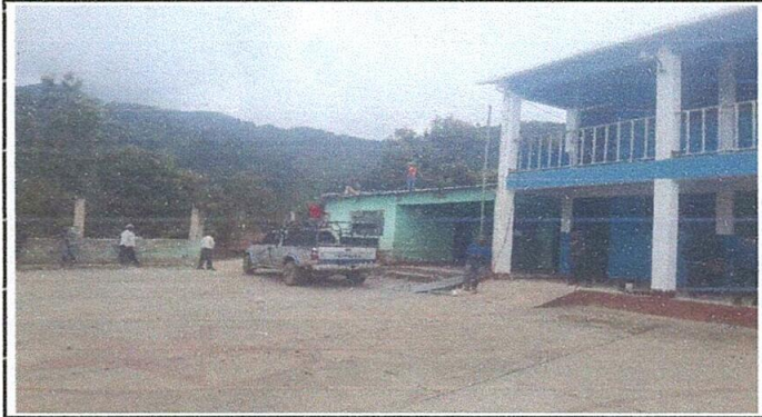
Foto 2: Reparación de muro perimetral.
