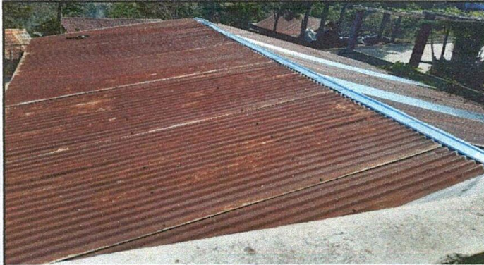
Foto 1: Sustitución de techo.
