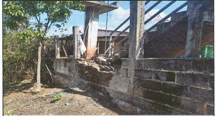
Foto 2: Reparación de muro perimetral.
