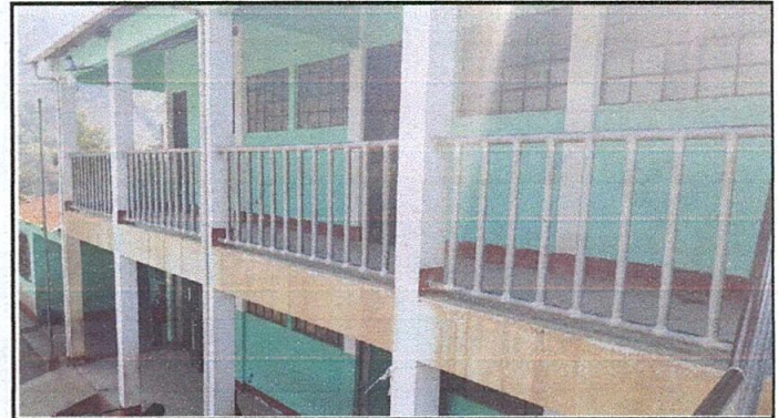
Foto 4: Mantenimiento a barandas.
