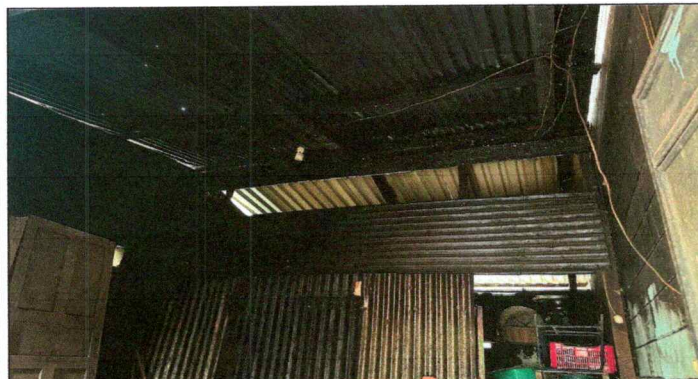
Foto 3: Las láminas están sujetadas en madera, necesita sustituirse por costaneras, para darle mayor seguridad, esto en el techo de la cocina.
