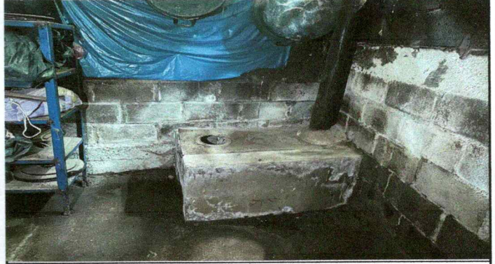
Foto 2: Las estufas artesanales se encuentran inservibles y es necesario hacer algunos arreglos para buscarle salida al humo.
