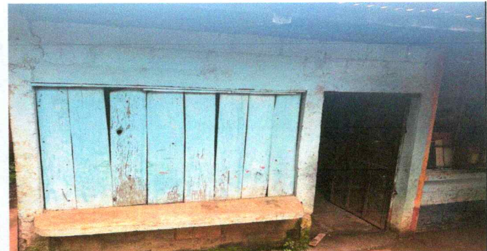
Foto 6: Se necesita cambiar esta ventana de madera, por una de metal. Pues se dificulta el abrirla y no es nada segura.
