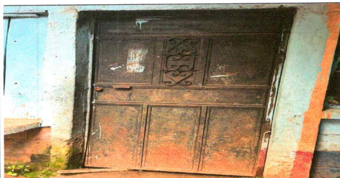
Foto 5: La puerta de la cocina está inservible, ya no se puede cerrar.
