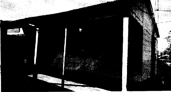
2. MEJORAMIENTO DE LA ESTRUCTURA DE TECHO
