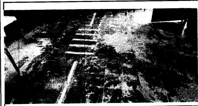
3. REPARACION DE PISO
