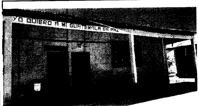
2. MEJORAMIENTO DE LA ESTRUCTURA DE TECHO
