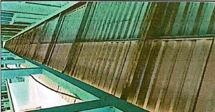
Foto 6: Cambio de tubo galvanizado y lamina troquelada.
