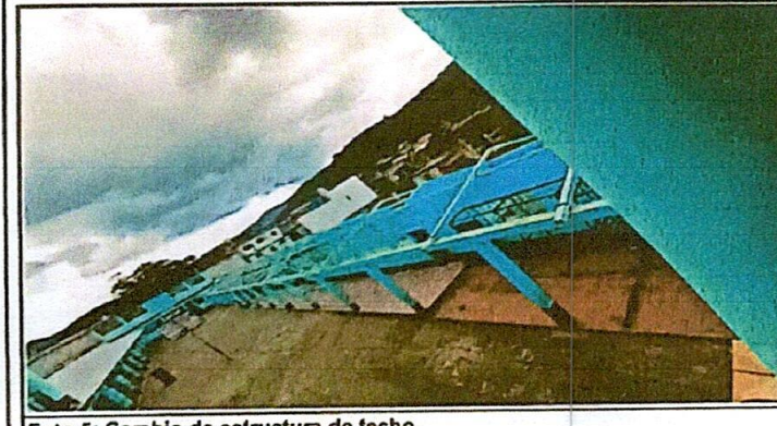
Foto 5: Cambio de estructura de techo.
