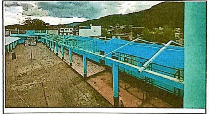
Foto 4: Colocación de tijeras con tubos 4xe4.
