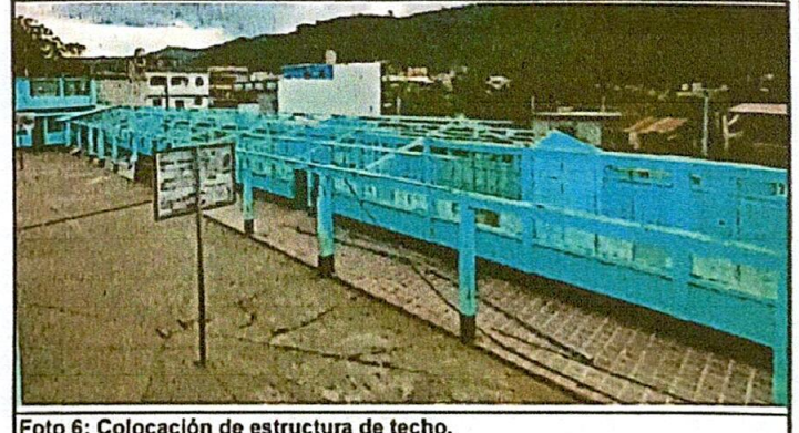
Foto 6: Colocación de estructura de techo.
