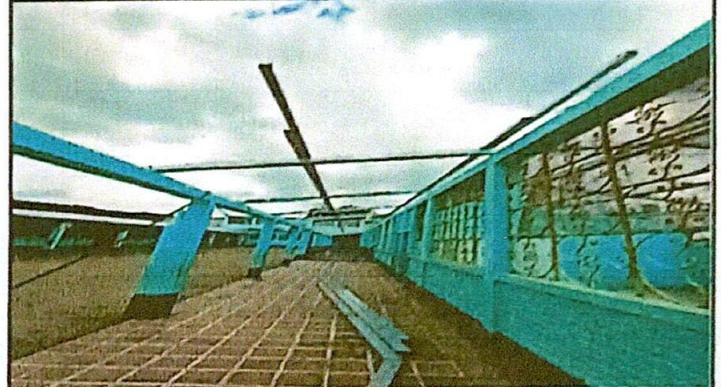
Foto 2: Colocación de tijeras y tendales.
