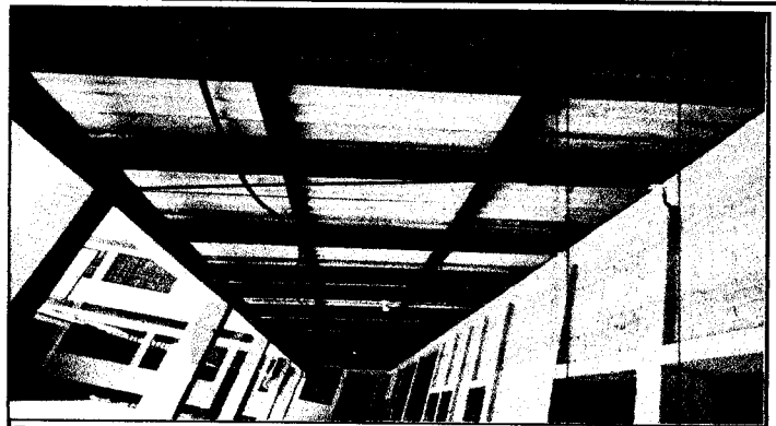
Foto 2: Estructura de madera en mal estado.
