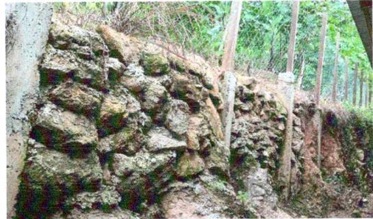
Foto 4: muro de contencion en malas condiciones
