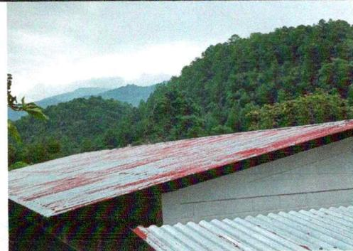
Foto 6: pintura de techo de lamina en mal estado
