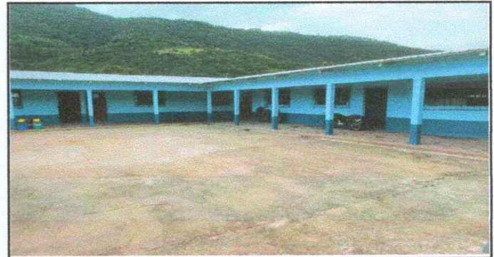
Foto 6: CANALES Y BAJADAS DE AGUA
