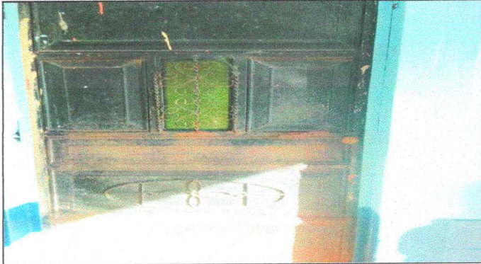
Foto 1: SUSTITUCION DE PUERTAS
