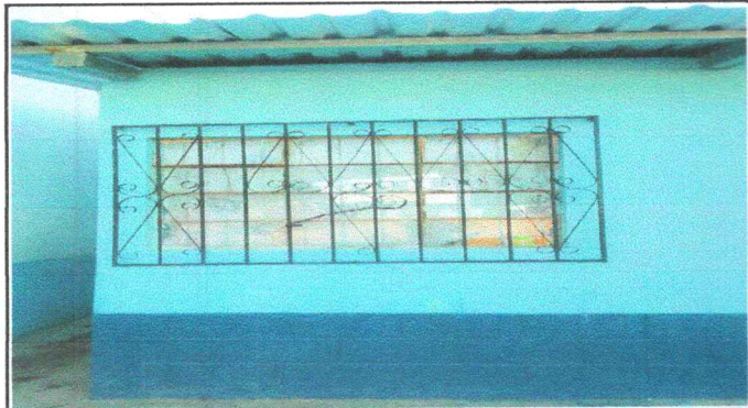
Foto 3: SUSTITUCION DE VENTANAS
