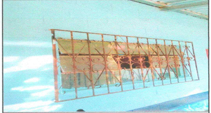
Foto 2: SUSTITUCION DE VENTANAS
