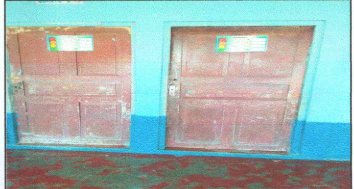
Foto 4: SUSTITUCION DE PUERTAS
