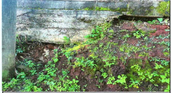
Foto 2: A causa de las fuertes lluvias los cimientos del muro están quedando al aire libre.
