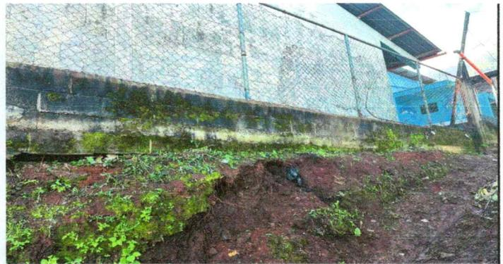
Foto 5: Se puede evidenciar el riesgo de derrumbe de este muro.
