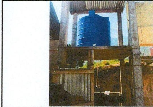
Foto 2: Sustitución de depósito de almacenamiento de agua.
