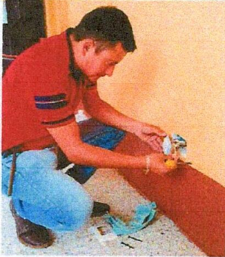
Foto 7: Sustitución de tomacorrientes.
