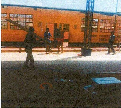
Foto 1: Sustitución de lámina de zin por lámina troquelada.
