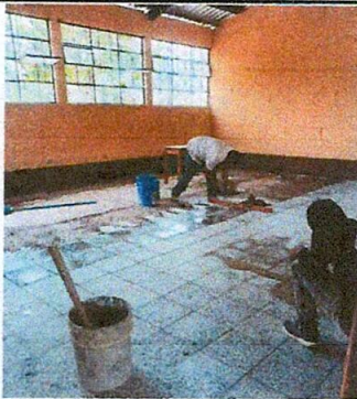
Foto 5: Sustitución de piso.
