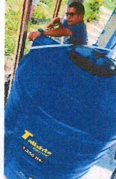
Foto 2: Sustitución de depósito de almacenamiento de agua.
