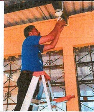
Foto 8: Sustitución de lámparas.
