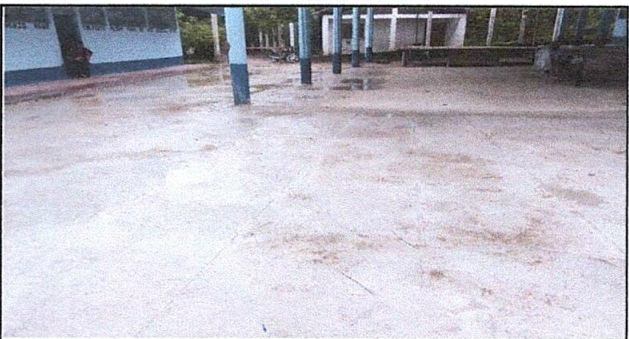
Foto 4: Sustitución de Piso
