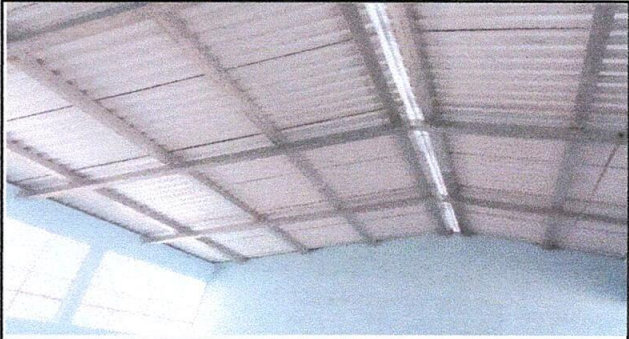
Foto 2: Cambio de Techo
