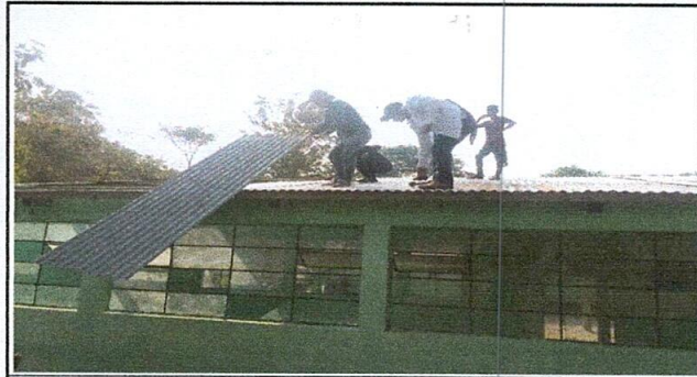
Foto 1: Cubierta de Techo
