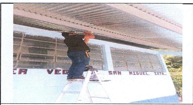
Foto 6: Sustitución de energía Eléctrica
