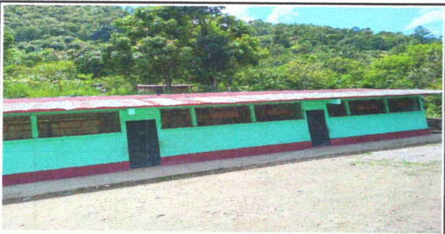
Foto 5: Cambio de techo del módulo por deterioro
