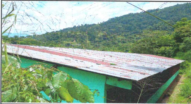
Foto1: Por deterioro de la lamina se hace la sustitución por lamina troquelada
