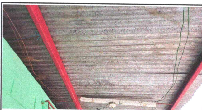
Foto 4: Sustitución de cable eléctrico por deterioro
