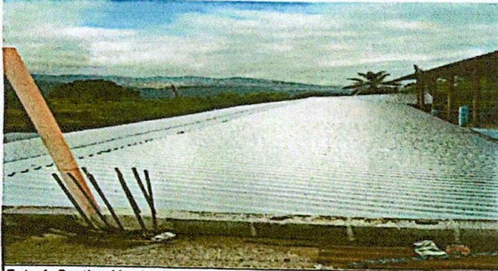
Foto 1: Sustitución de lámina por lámina troquelada calibre 26
