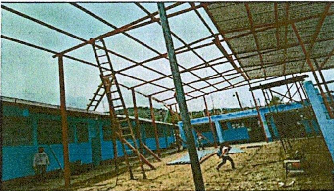
Foto 3: Sustitución de hierro por costanera
