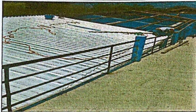
Foto 1: Sustitución de lámina por lámina troquelada calibre 26
