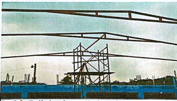
Foto 5: Sustitución de madera por estructura portante
