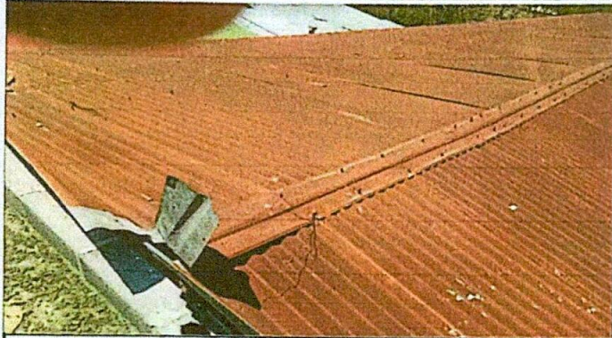
Foto 1: Sustitución de lámina por lámina troquelada calibre 26
