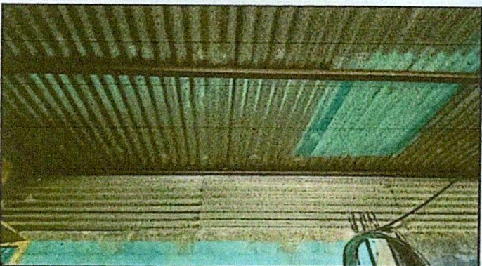
Foto 3: Sustitución de hierro por costanera
