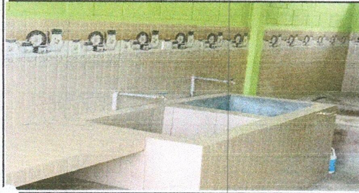
Se cambió una pila viejita por un pequeño tanque con lavadero y mesa con azulejo en el interior de la cocina
