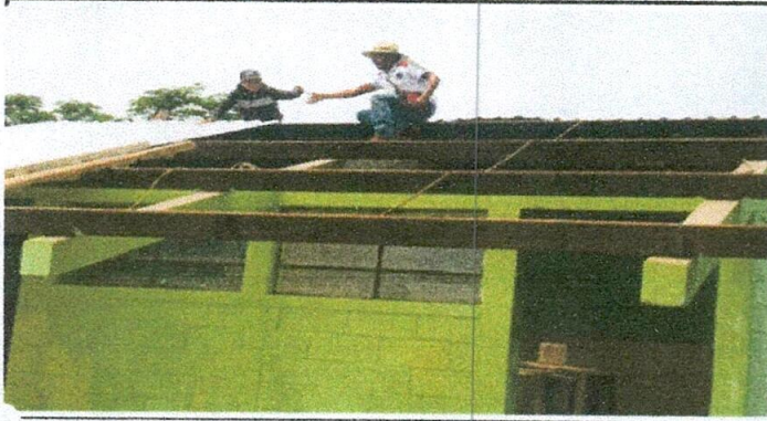
Padres de familia trabajando en la remodelación de techo de la dirección de la escuela
