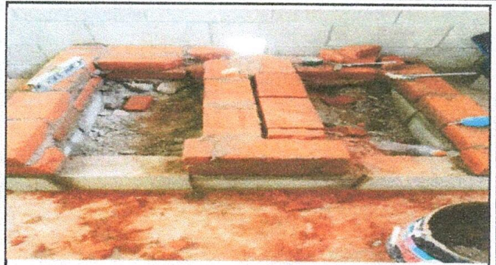
Construcción de tres pollos o estufas industriales en el interior de la cocina de la escuela.
