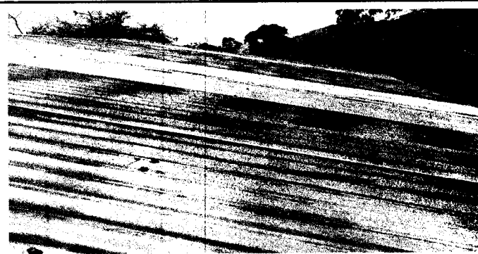
FOTO 3: SUSTITUCIÓN DE TECHO DE LAMINA DE CINC POR LAMINA TROQUELADA CALIBRE 26.
