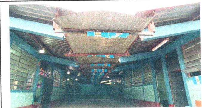
Foto 1: SUSTITUCION DE LAMINA Y ESTRUCTURA DE CORREDOR Y COLOCACION DE CANAL PVC
