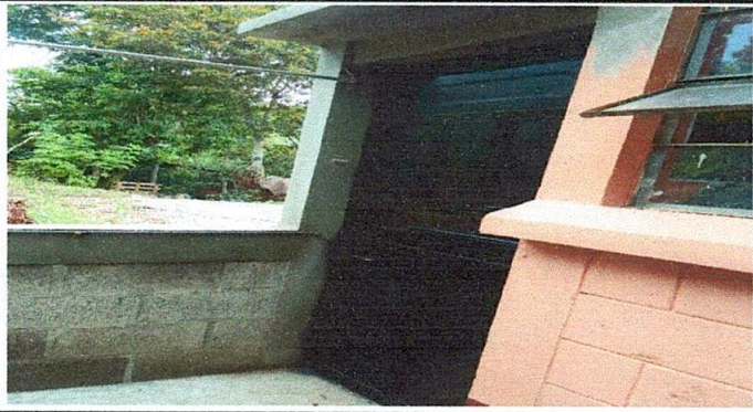
Foto1: Sustitución Puertas de Metal
