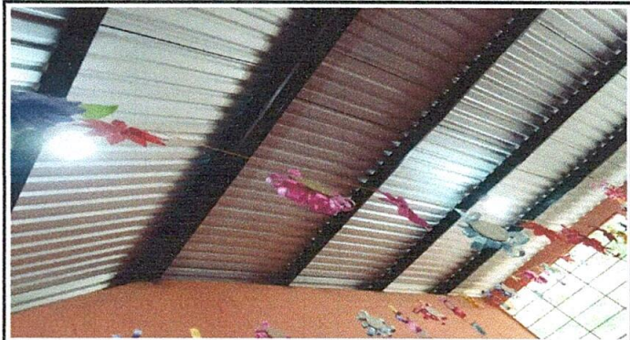
Foto 2: Reparación de Sistema Eléctrico
