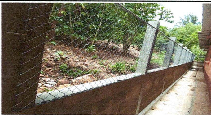
Foto 3: Construcción de Muro Perimetral
