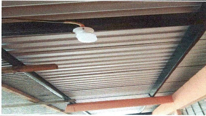
Foto1: Reparación Sistema Eléctrico
