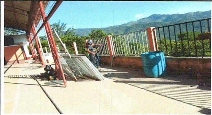
Foto 2: Instalación de Barandas
