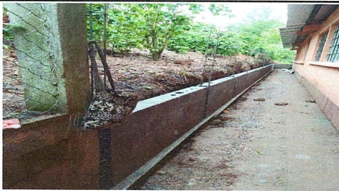
Foto 3: Construcción de Muro Perimetral
