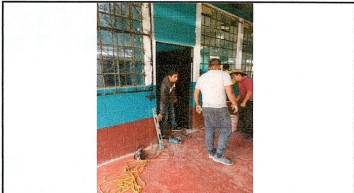
Foto 3: Acá están cambiando las puerta de la biblioteca.
