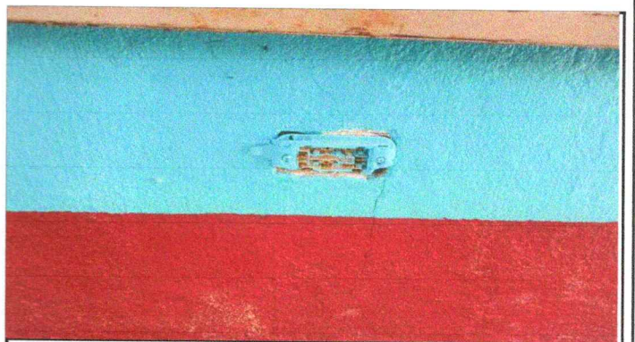
FOTO 4: CAMBIO DE SISTEMA ELECTRICO
