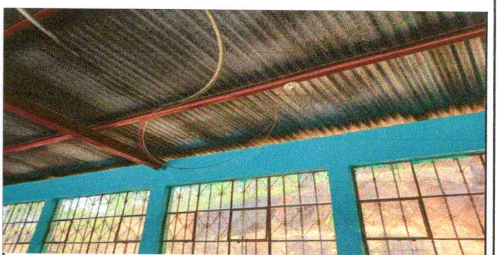
FOTO 6: INSTALACIÓN DE ENERGIA
