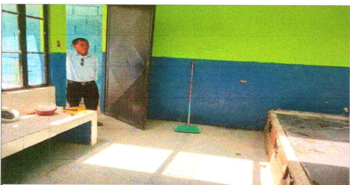
FOTO 5: PINTURA EN MUROS INTERIORES
