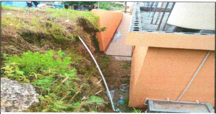
FOTO 3: REPARACION DE CIRCULACIÓN
