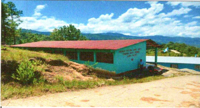
FOTO 1: CAMBIO DE TECHO
