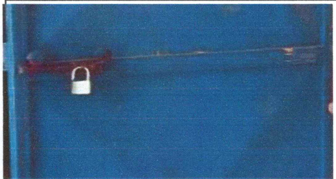
FOTO 2: SUSTITUCIÓN DE CHAPA
