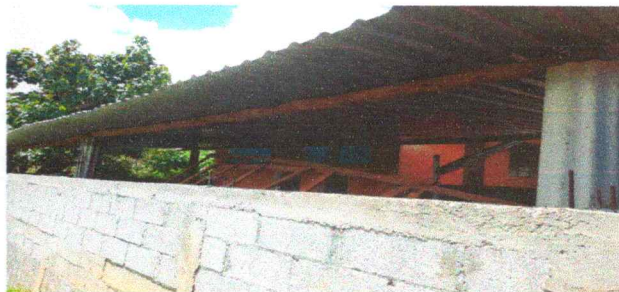
FOTO 8: REPARACIÓN DE MURO
