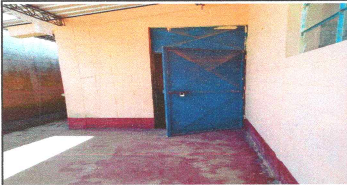
FOTO 1: MANTENIMIENTO A ESTRUCTURAS
