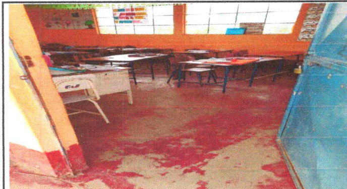
FOTO 3: SUSTITUCIÓN DE PISO DE TORTA A GRANITO
