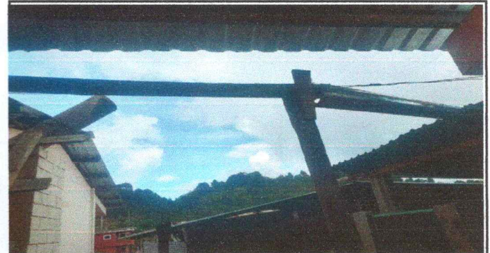
FOTO 4: SUSTITUCIÓN DE CANALES DE PVC
