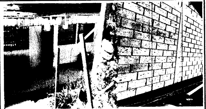
Foto 2: Por detriero de la pintura con el ambiente en 2 modulos de aulas, se renovará el pintado de los mudulos.
