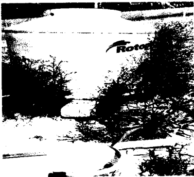
Foto 3: Por la poca capacidad de almacenamiento de agua en epoca de invierno, se sustituirá con un depósito de mas capacidad.
