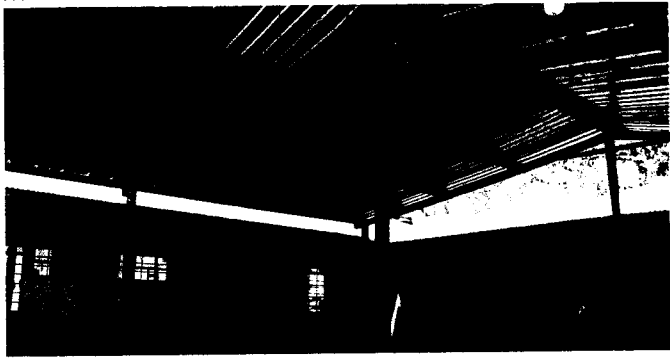
Foto 1: Por la antigüedad y deterioro de canales improvisados, se sustituirá por material nuevo (TUBOS DE PVC)
