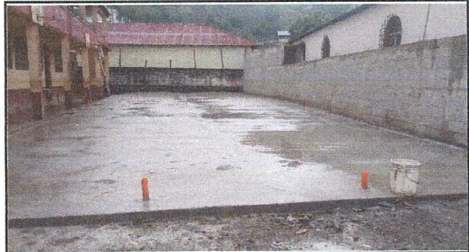
Foto 4: se ha realizado la fundición de la segunda parte del patio del establecimiento
