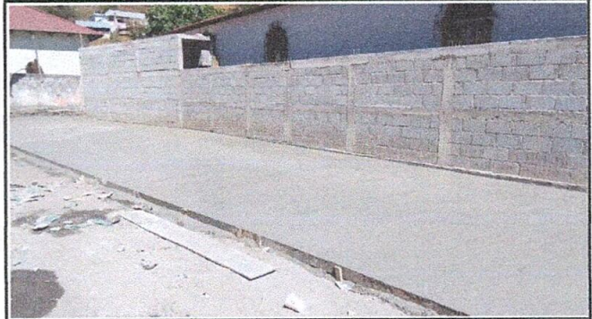
Foto 2: se ha realizado la fundición de la primera parte del patio
