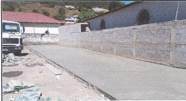
Foto 1: los albaniles y ayudantes han realizado la fundición de la primera parte del patio
