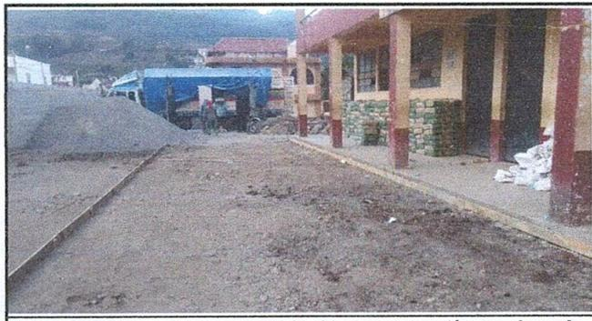
Foto 5: el terreno ha sido compactado el terreno y se está recepcionando el material
