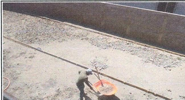
Foto 3: los albañiles han compactado el terreno
