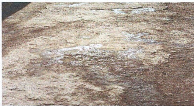
Foto 1: sustitución de piso de torta de concreto
