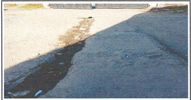
Foto 4: sustitución de piso de torta de concreto
