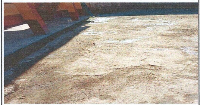
Foto 2: sustitución de piso de torta de concreto en patio
