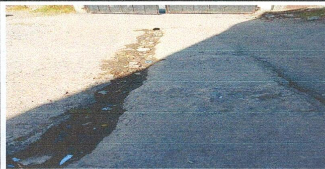
Foto 5: sustitución de piso de torta de concreto
