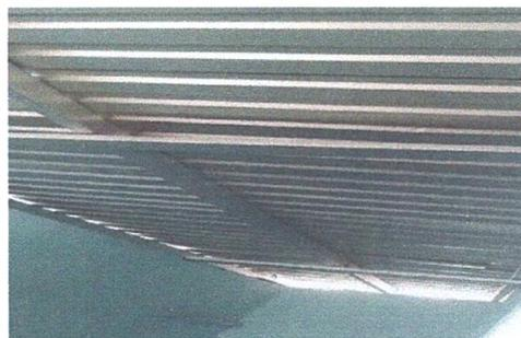
Foto 6: laminas instaladas con su respectiva costaneras.
