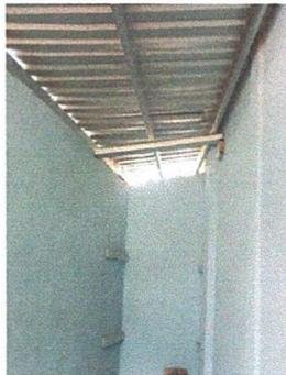
FOTO 3: A la vista se ve el cambio de techo de las dos areas Bodega de alimentos y Direccion, y la Pintada de pared deteriorada.
